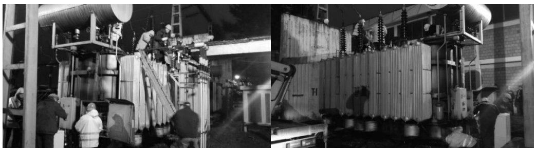
SLIKA 5 – DEMONTAŽA ENERGETSKOG TRANSFORMATORA
