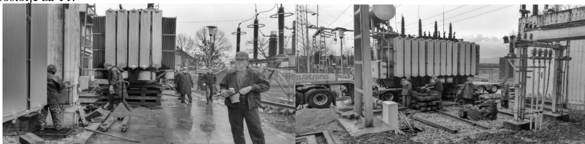
SLIKA 6 – UTOVAR ENERGETSKOG TRANSFORMATORA
